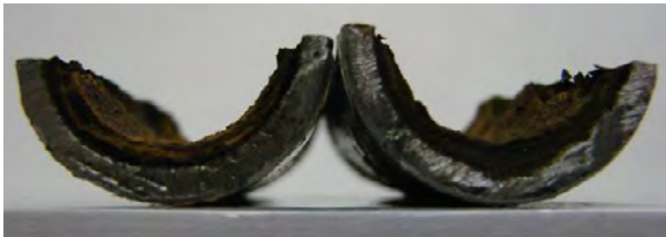
Рис. 2. Исходная поверхность участка трубопровода системы отопления.
